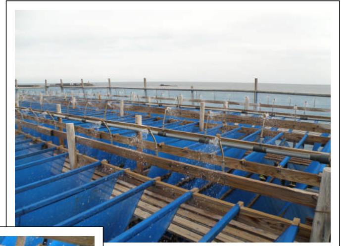
毎分 50 リットルのペースで汲み上げられた海水は3層の地下タンクに貯蔵さ れ、更にポンプで地上約8メートルの高さにある噴出口に送られます。
