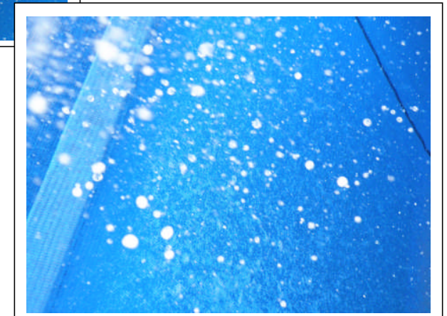
噴撒した海水は、ネットを伝わってどんどんカン水施設下部へ落 ちていきます。この間に風と太陽熱によって、水分が徐々に蒸発 していきます。
