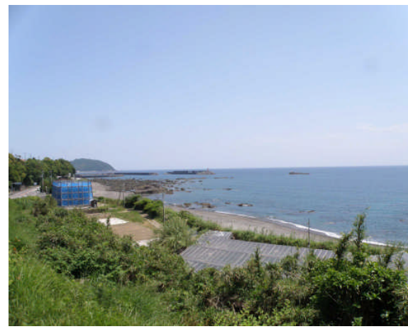
高知県幡多郡黒潮町の海岸線「王無浜」に立つ、 【(有)海工房】のカン水施設(海水濃縮施設)です。
