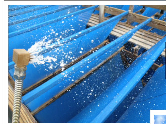
カン水施設屋上の様子です。 カン水施設に張り巡らされたネットに向かって、 噴出口から海水が勢い良く、噴撒されています。
